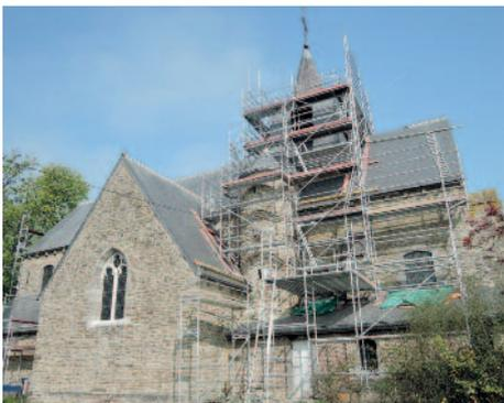
Après avoir renouvelé complètement la couverture des toitures, les travaux se sont poursuivis avec le renouvellement de l'installation électrique. Le nouveau câblage est placé. Les travaux en sont à la réfection des enduits. Une nouvelle installation de chauffage
