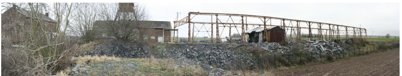
Figure 143: vue sur les installations de surface de la carrière de la Fausse Cave depuis le sud (source : Aménagement sc 2017)
