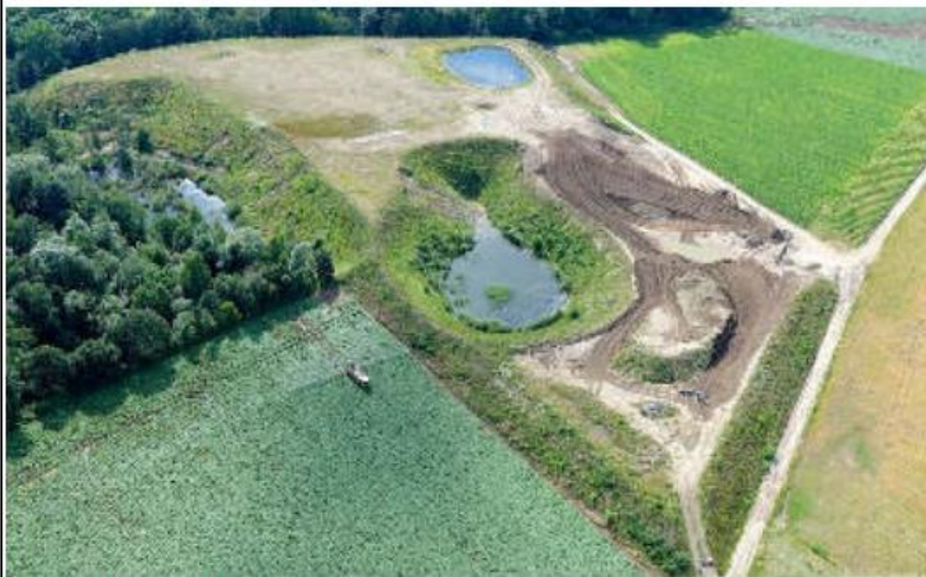
Vue aérienne au 06 juillet 2016
