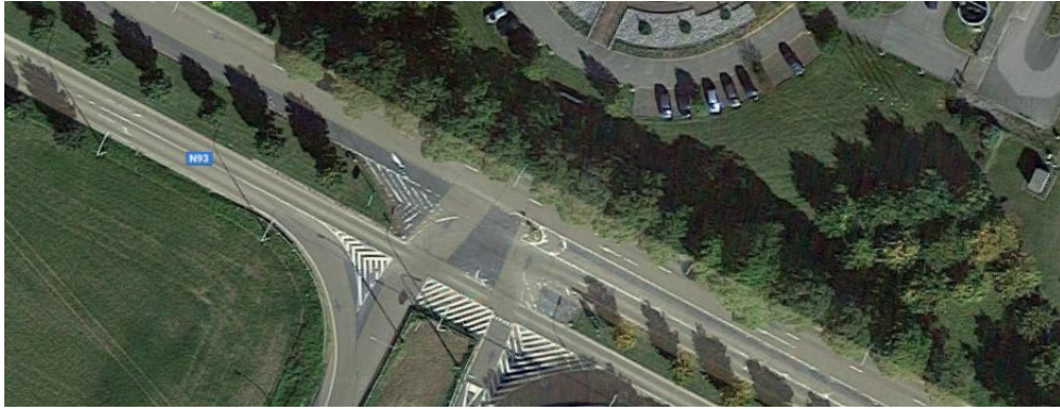
Figure 113 : Vue du profil de la N93 sur son tronçon sortie 13 E42/giratoire Hubert (source Google Earth)
