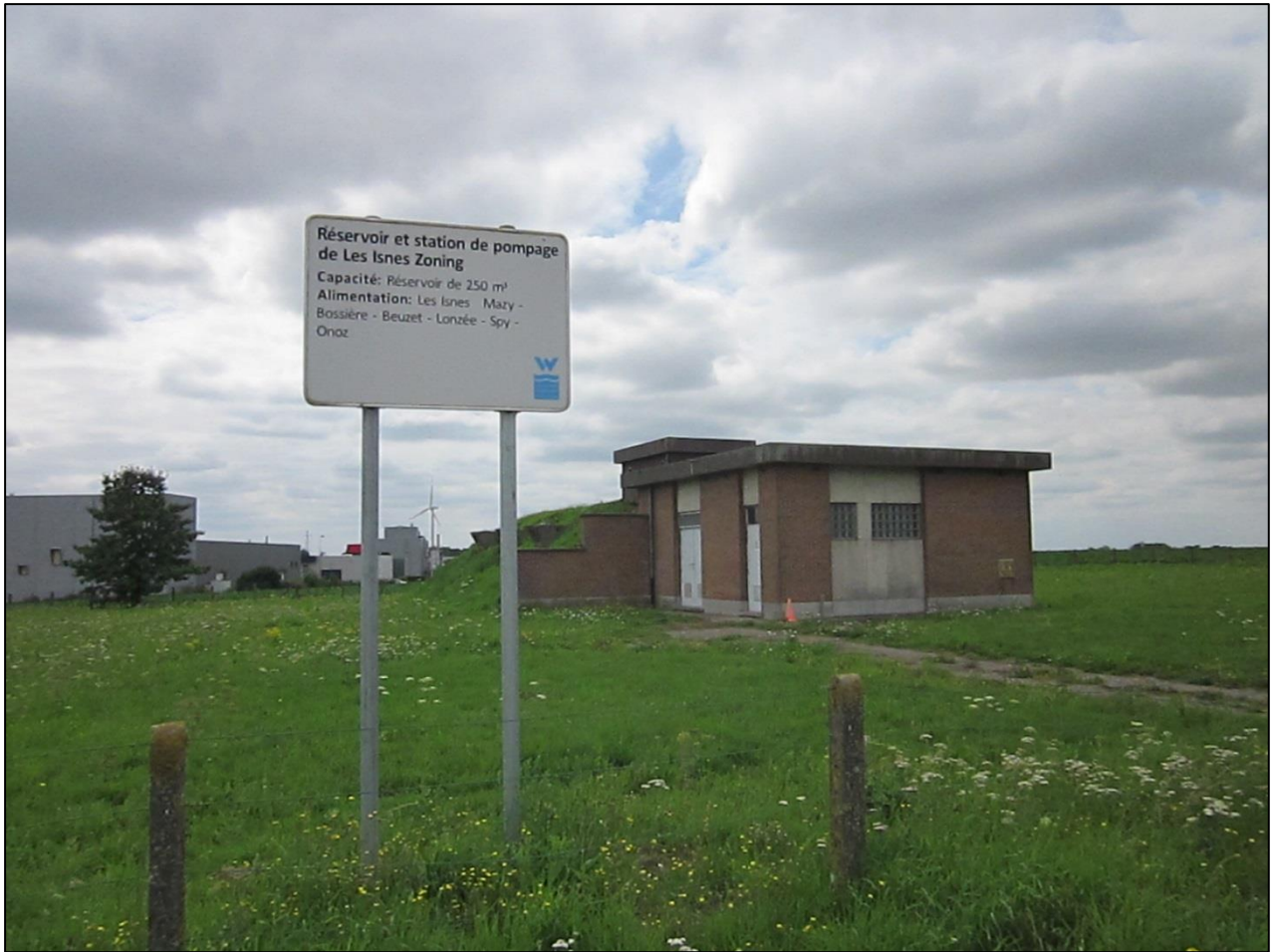
Figure 44 : Station de pompage des Isnes - Rue de Florival (Reportage Photo, 2017)
