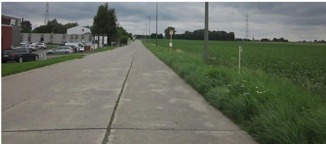
Figure 116 : Vue de la rue Saucin en direction du village (source Google Maps)
