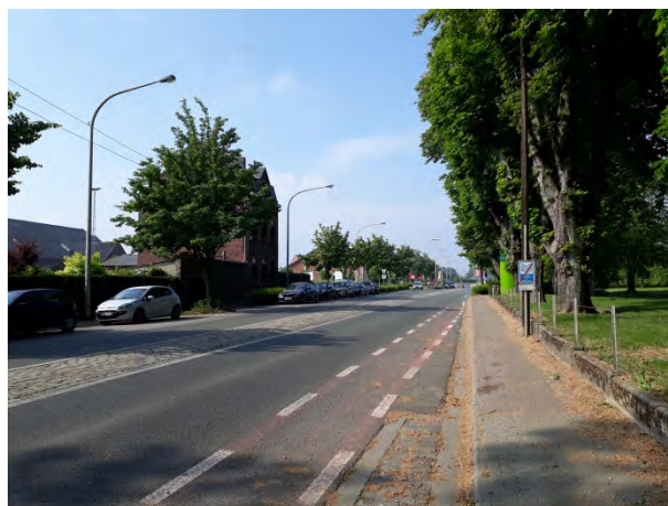
Photos 28-29 : Vues de la Chaussée de Tirlemont
