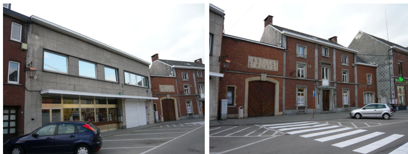
Bâtiments occupés par le Collège Saint-Guibert
