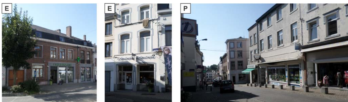
Figure 2-20 : photographies - exemples de bâtiments à vocation commerciale dans le centre-ville avec deux exemples de bâtiment commercial intégré (deux exemples à droite) et de bâtiments commerciaux en rupture avec son contexte (deux exemples sur la photographie de gauche)
