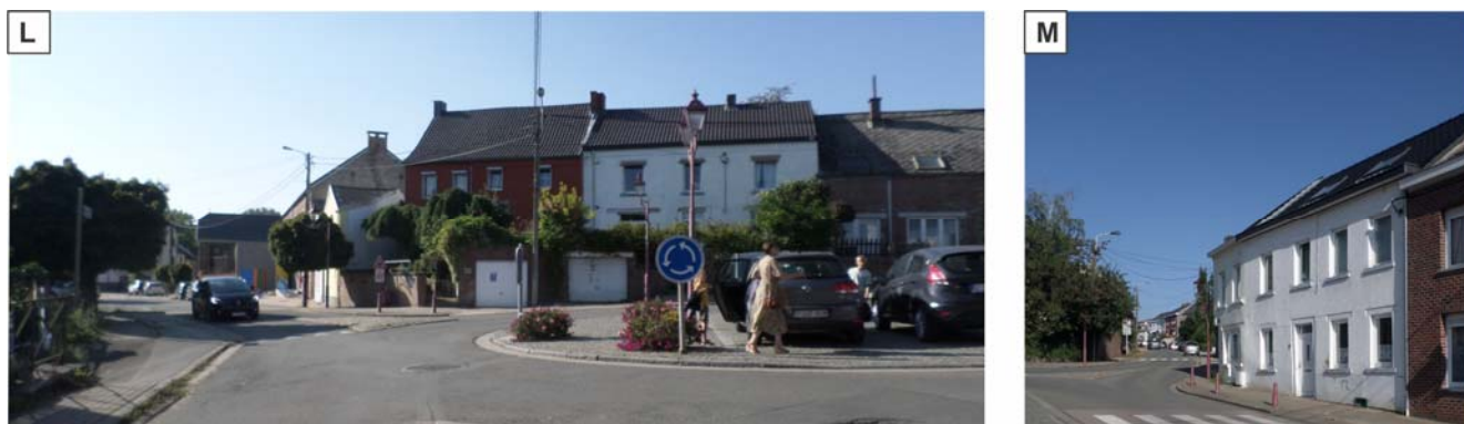
Figure 2-18 : photographies du centre du village de Grand-Manil
