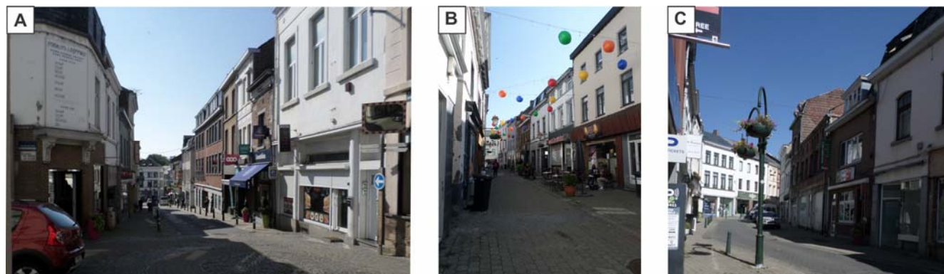
Figure 2-12 : photographies de la trame bâtie du centre-ville
