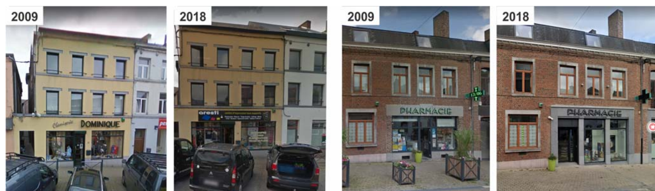
Figure 4-1 : photographies des façades de deux bâtiments localisés au centre-ville à Gembloux avant et après implantation d'une nouvelle cellule commerciale
