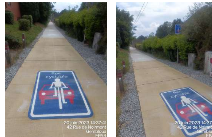
Rue cyclable à Ernage, drève de Linoy
