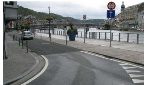
Accès à une zone 30 avec changement de revêtement
