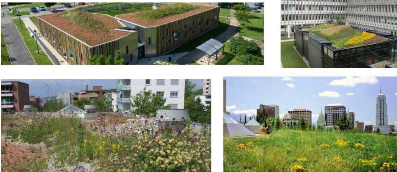
Figure 30 Référence d'aménagement de toitures (source : JNC International, 2021)
