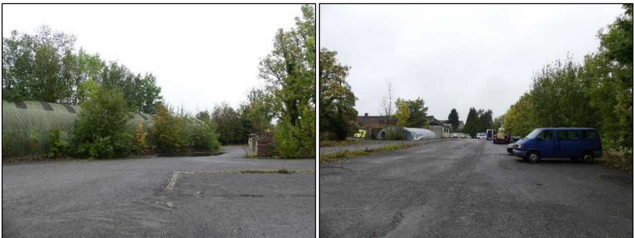
Figure 118 Vues 5 et 6 : Zoom sur la friche industrielle (source : CSD Ingénieurs, 2020)
