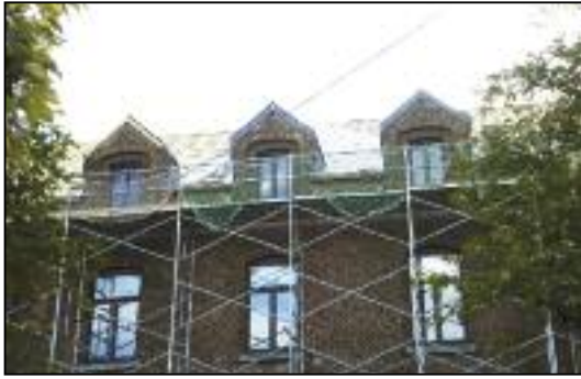
Renouvellement de la couverture de toiture de la maison communale de Grand-Leez
