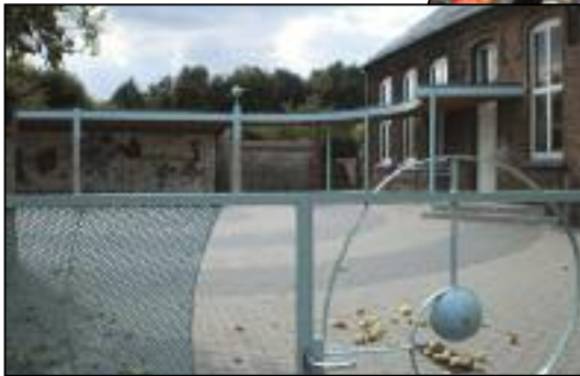
Préau et aménagements PMR à l'école de Ernage
