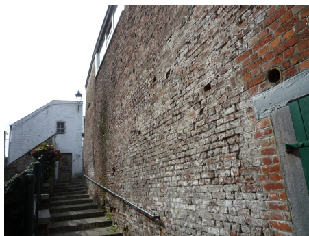
Vue depuis la venelle Saint-Sauveur et les escaliers, ruelle Thirion
