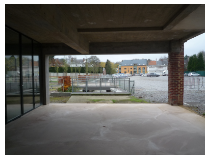
Parvis du bâti rénové
