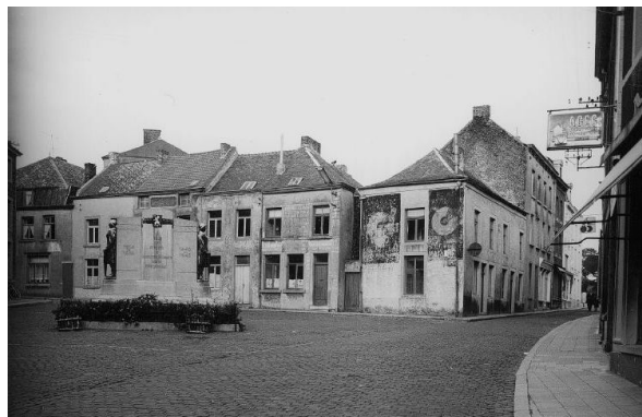
Bâti séparant la place St Jean et la place St Guibert avant démolition (1961)
