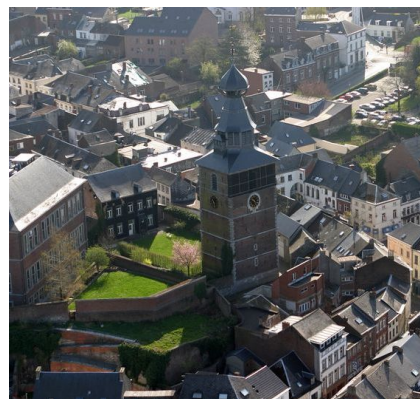
Vue sur la terrasse verte panoramique
