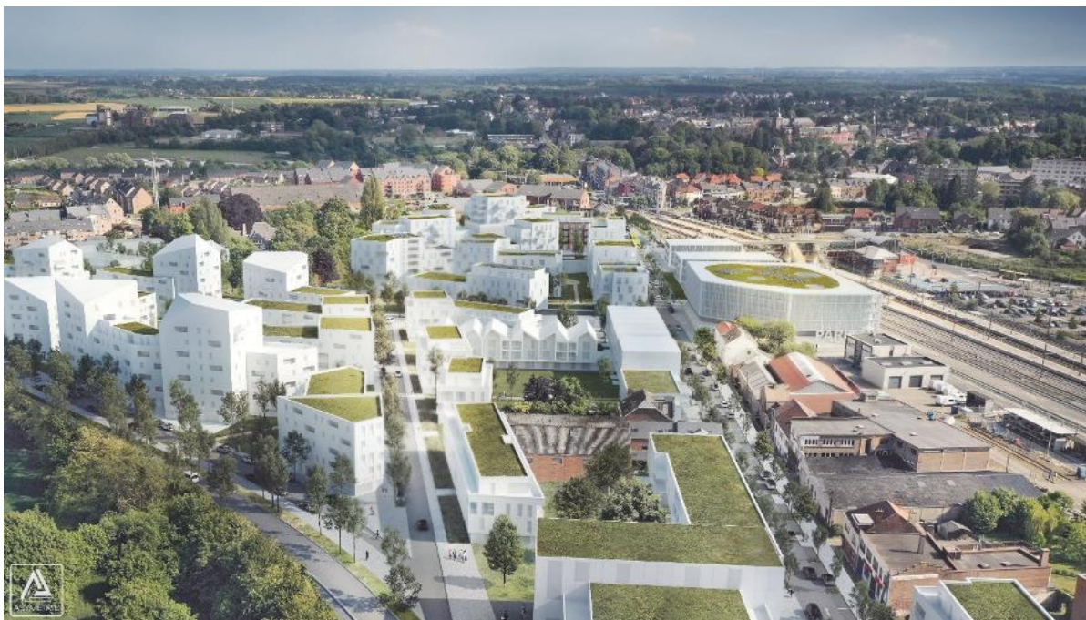
Figure 58 : Vue vers le sud
